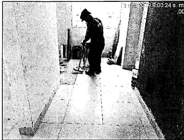
Foto N° 01: Area de administración: Fraguado de porcelanato.
