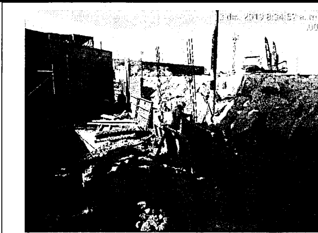
Foto N° 15 y 16: PTAR Y CERCO PERIMETRICO: tarrajeo exterior de los componentes de la PTAR, construcción d cerco perimetrico.
