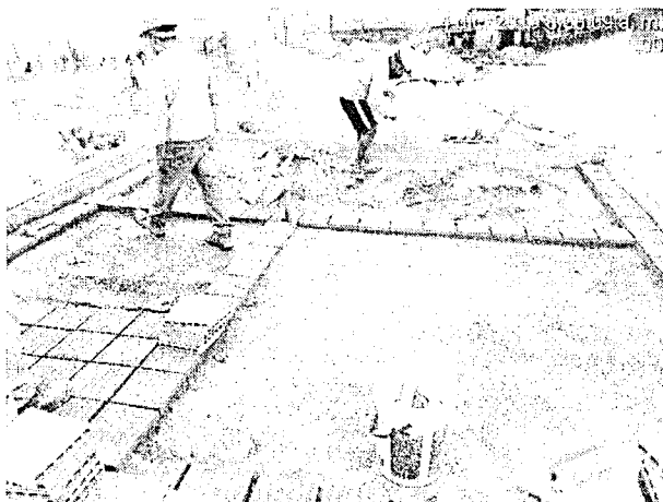
Foto N° 02 y 03: Area de Talleres: colocacion de ladrillo pastelero, tarrajeo exterior.
