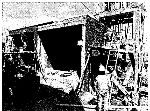
Foto N° 02 y 03: Area de Talleres: colocacion de ladrillo pastelero, tarrajeo exterior.
