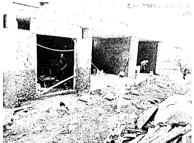
Foto N° 02 y 03: Area de Talleres: colocacion de ladrillo pastelero, tarrajeo exterior.
